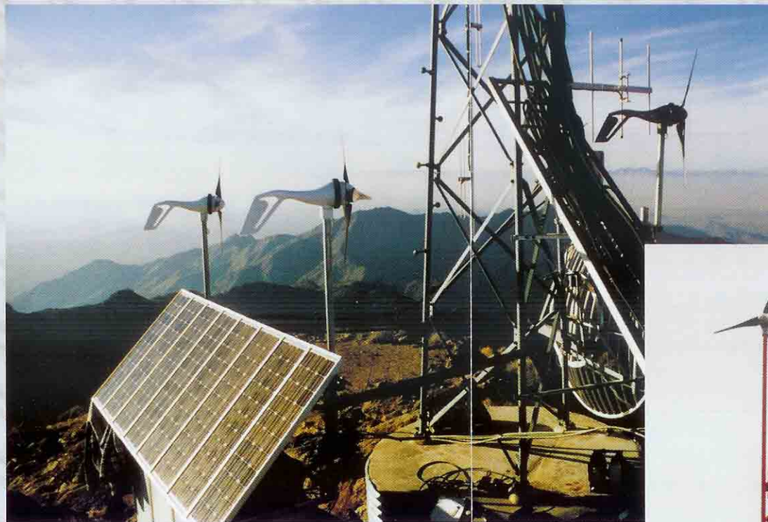
Drei AIR Industrial garantieren die Stromversorgung eines Telefon Transmitters in den Bergen von Phoenix, Arizona, USA.
